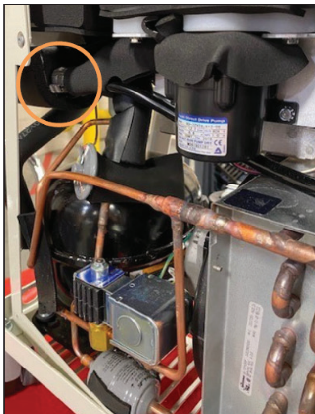
Fig. 8-22 Koppla loss två klämmor (steg 3 – DC-pump)
